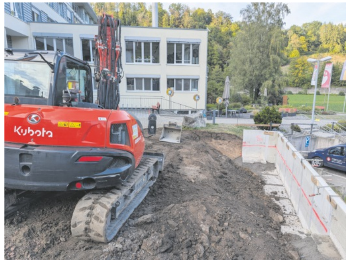
Die vorbereitenden Bauarbeiten für die neue Fertig-Fahrradbox sind in vollem Gang.
