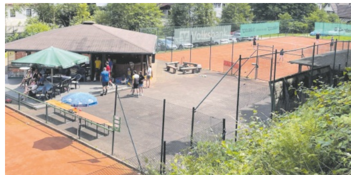
Tennisanlage kurz vor Sanierung
