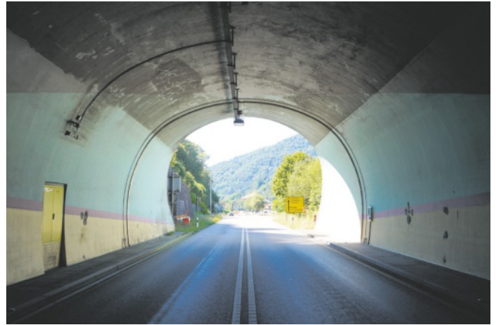
Kirchbergtunnel in Fahrtrichtung Vorderlehengericht
