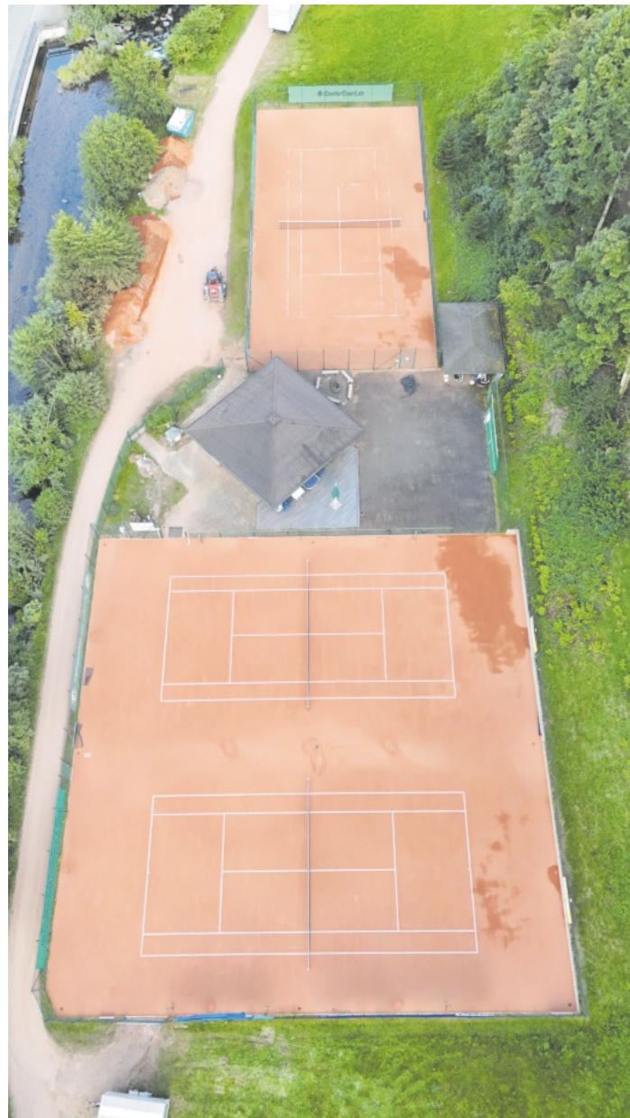
Blick von oben auf die neuen Plätze
