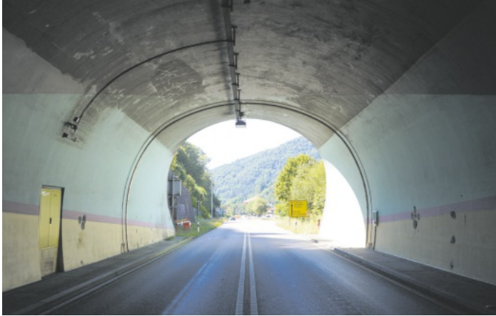
Kirchbergtunnel in Fahrtrichtung Vorderlehengericht
