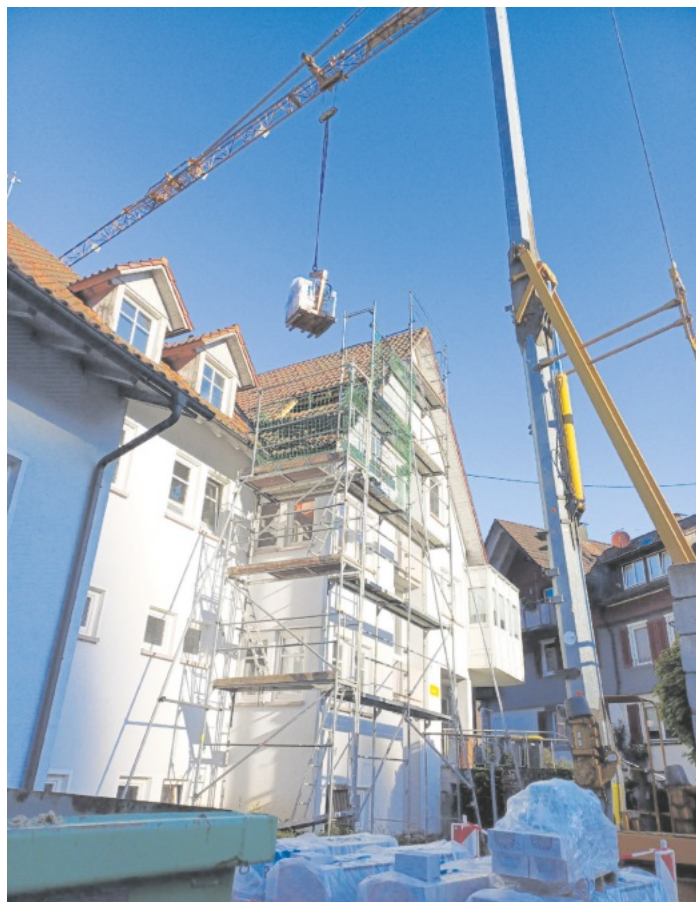
Einbringung von Materialien für Maurerarbeiten
