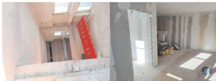
Durchbrüche für Aufzugsschacht | Hebammenpraxis
