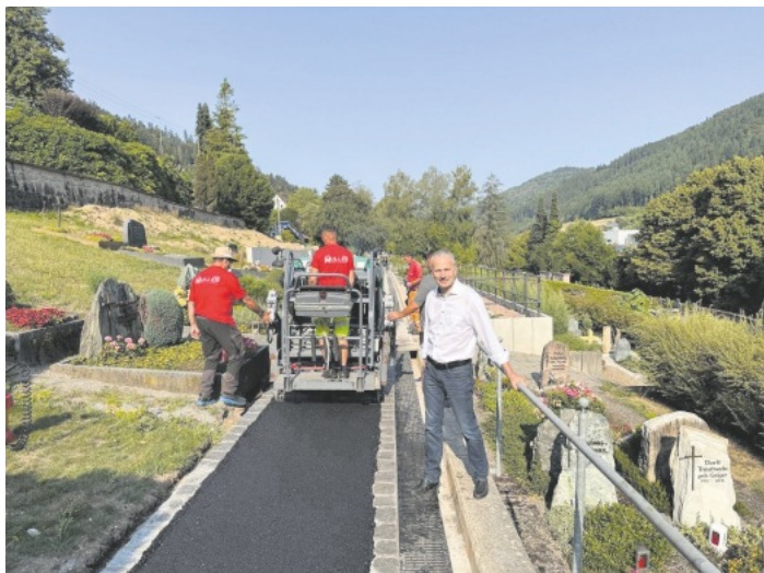
Friedhof erste Teilbereiche aus Bauabschnitt 2 werden fertig Foto: A. Hoffmann
